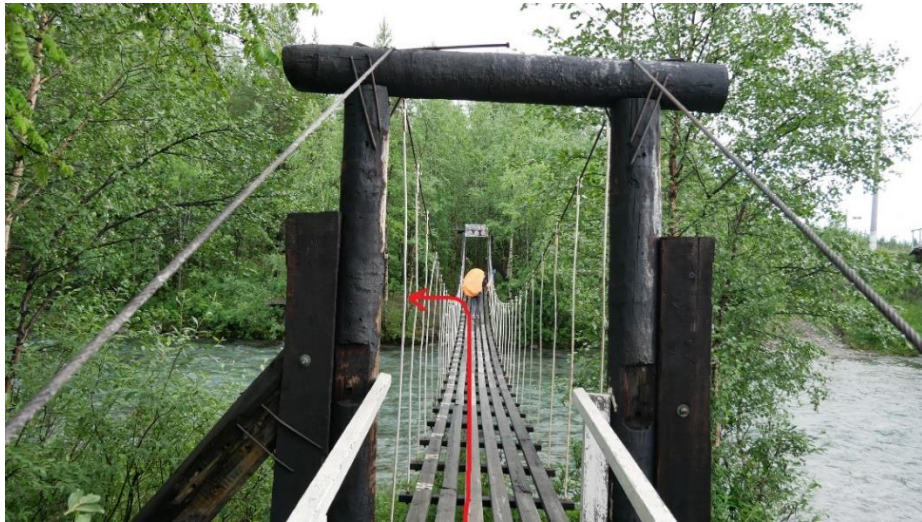
Фото 4. Мост через р.Гольцовка
