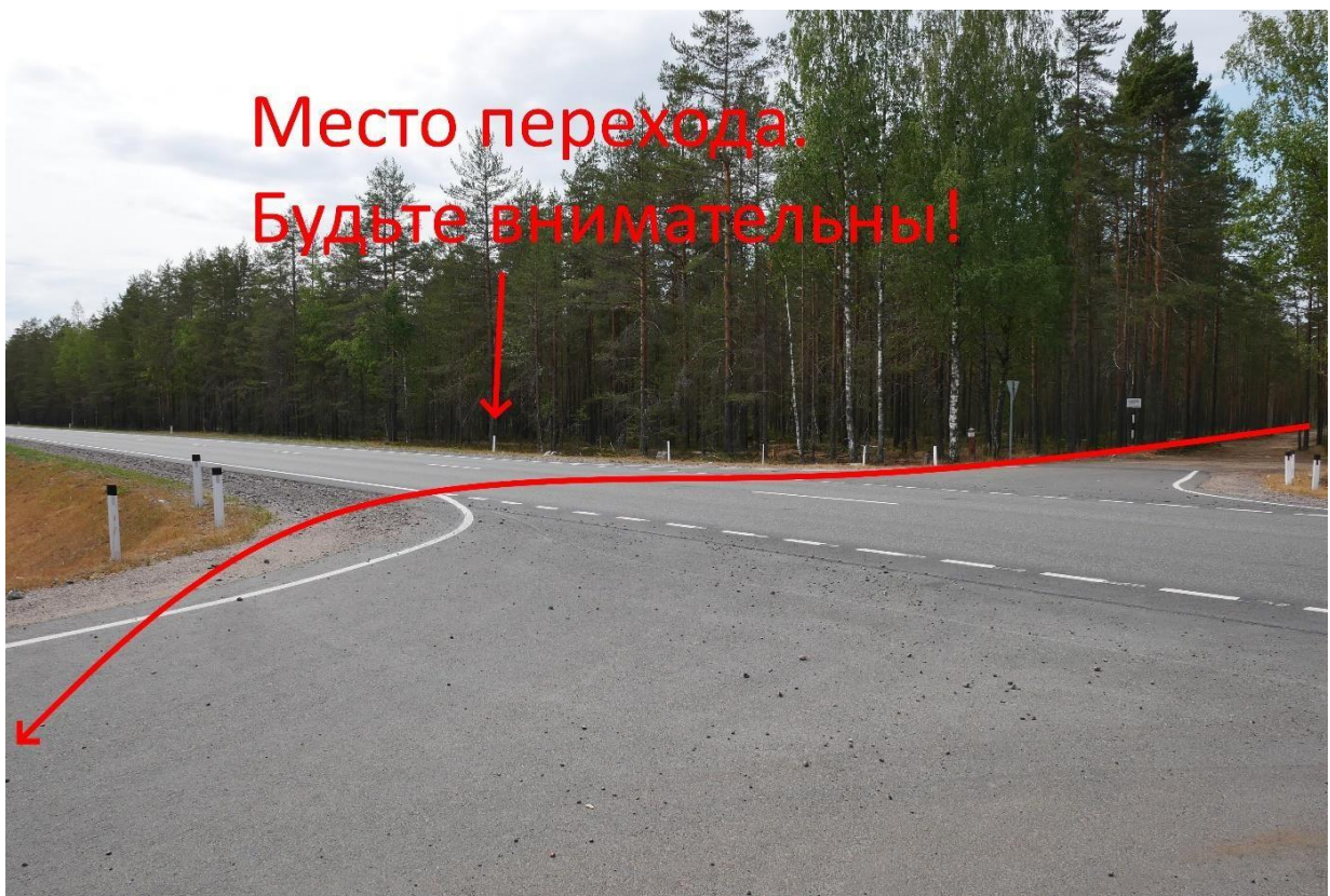
Фото 7. Место перехода трассы «Сортавала»
